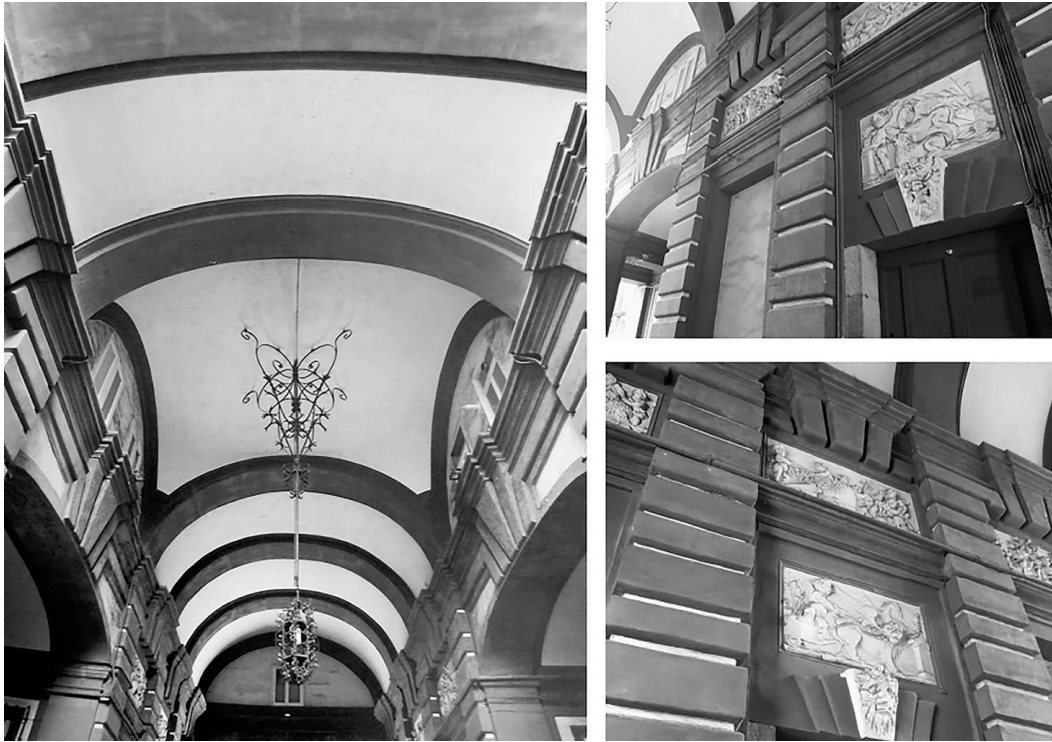
Fig. 3. Napoli, Palazzo Sansevero, pilastri bugnati nell'atrio d'ingresso (foto dell'A. 2015)
