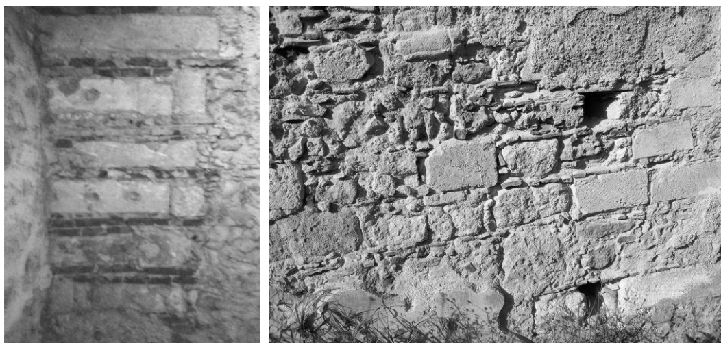
Fig. 6a. Tessitura muraria riconducibile alla fase cinquecentesca del complesso (foto degli AA., 2019)
