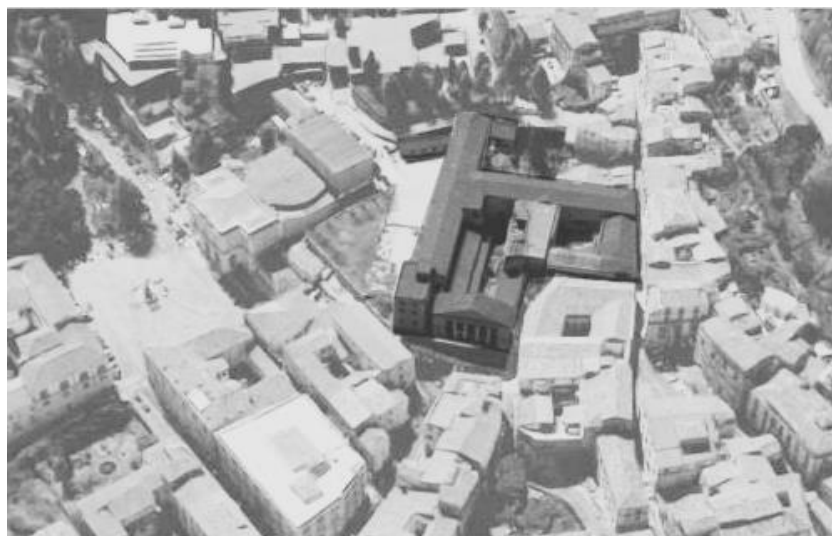
Fig. 1. Aerofotografia del fronte nord (elaborazione degli AA., 2019)
