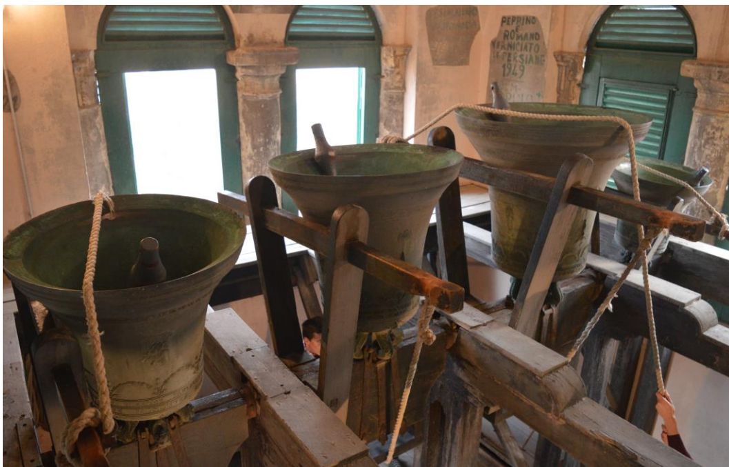
Fig. 3. Le campane della chiesa di San Procolo in posizione capovolta alla fine di un'esecuzione (foto di Michele Avenali).
