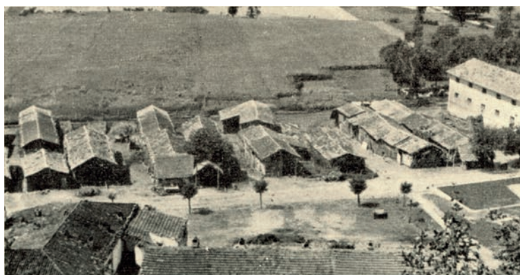
Fig. 1. Azienda Baraccone, Torcino - Mastrati. Abitazioni coloniche e stalle (in PEDRESCHI, 1964)
