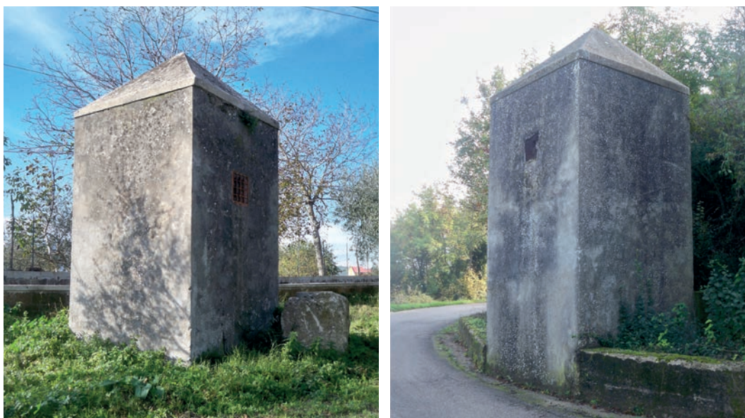
Fig. 2. I torrini lungo il percorso dell'Acquedotto Carolino.
