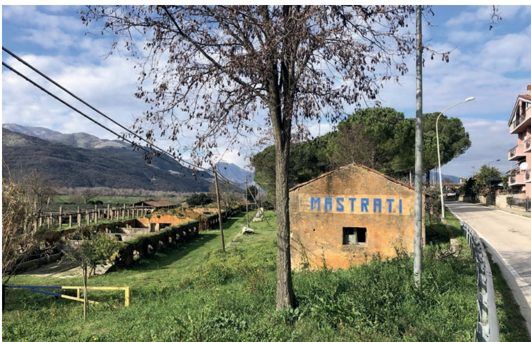
Fig. 8. Mastrati, l'ingresso al borgo agricolo (foto G. Pignatelli Spinazzola).
