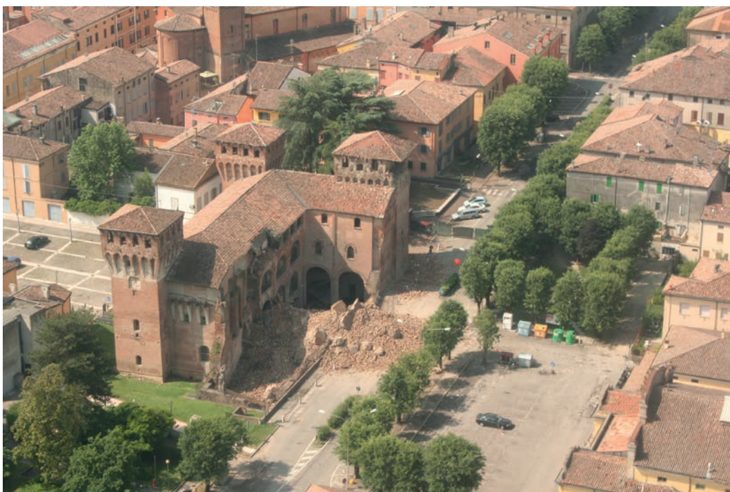
Fig. 5. Castello di Finale Emilia (MO), Sisma Emilia Romagna 2012. Il crollo totale del Mastio segna una ferita profonda nell'identità del castello e pone fortemente il tema della riedizione della lacuna come tema complesso e sostanziale nel progetto di restauro.
