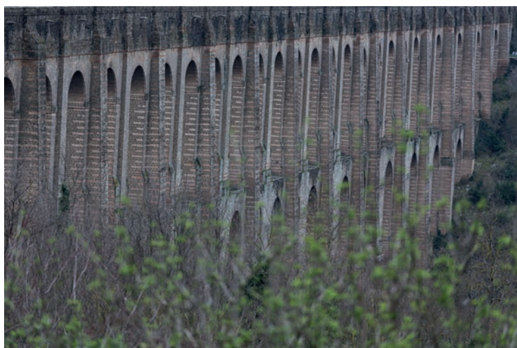
Fig. 1. I Ponti della Valle lungo il percorso dell'Acquedotto Carolino (foto di Luca Canonici).
