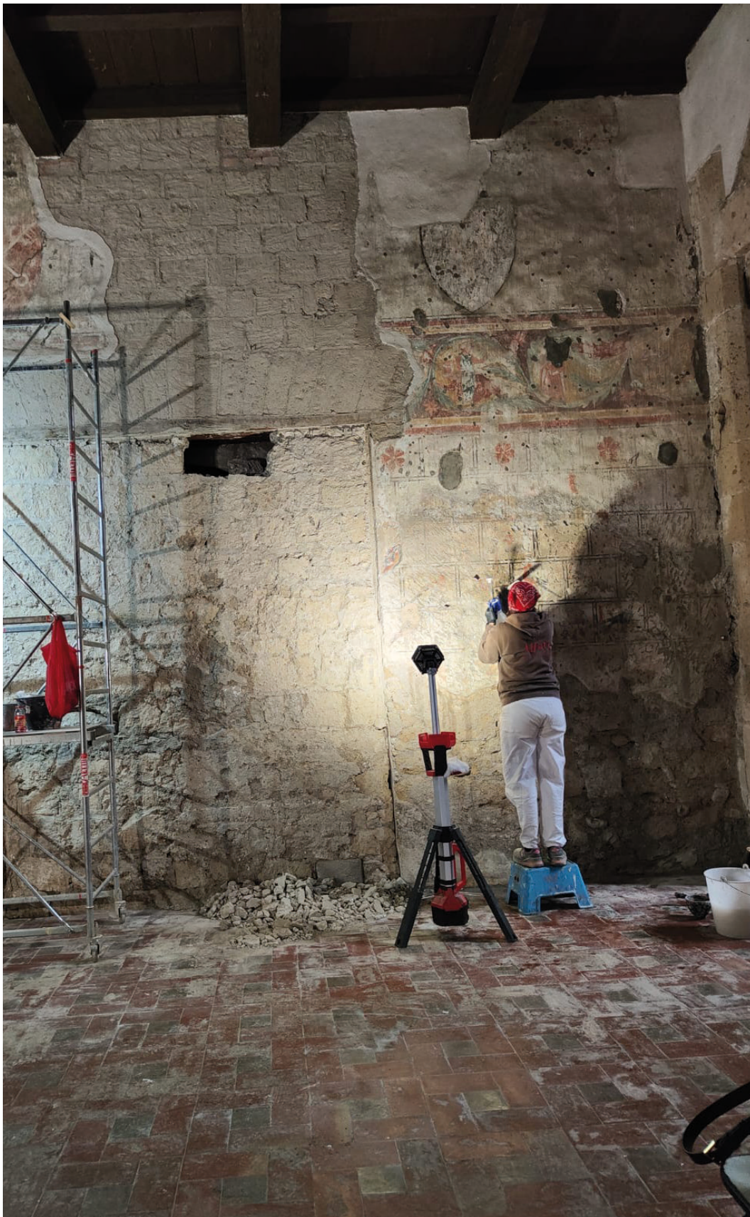
Chiesa Santa Maria Jacobi, foto di cantiere durante i lavori di restauro.
