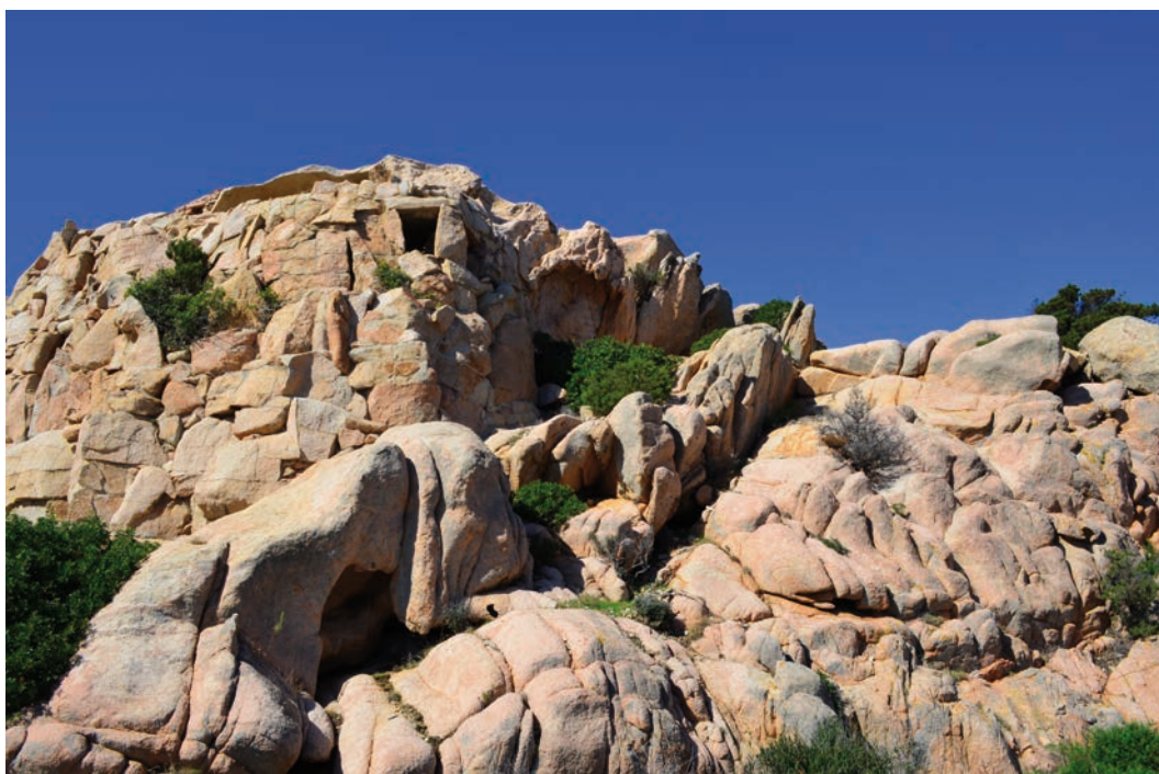
Fig. 11b. Caprera (La Maddalena, OT), batteria di Candeo, veduta degli accessi alle gallerie perfettamente mimetizzati nel costone roccioso di granito (D.R. Fiorino).
