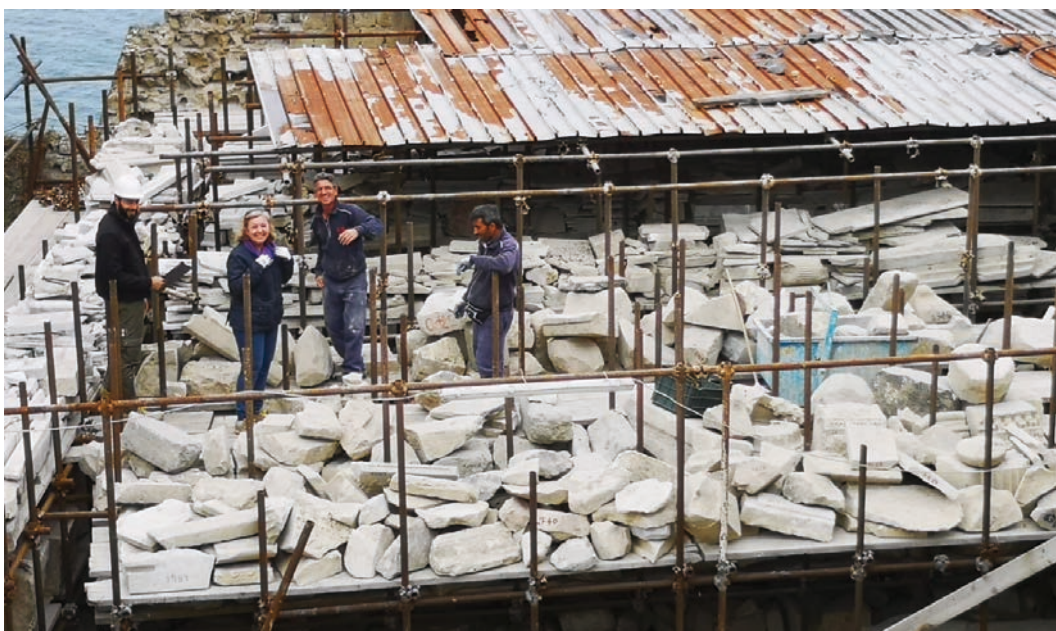
Figg. 11 -12. Smantellamento del deposito dei marmi, foto di cantiere.
