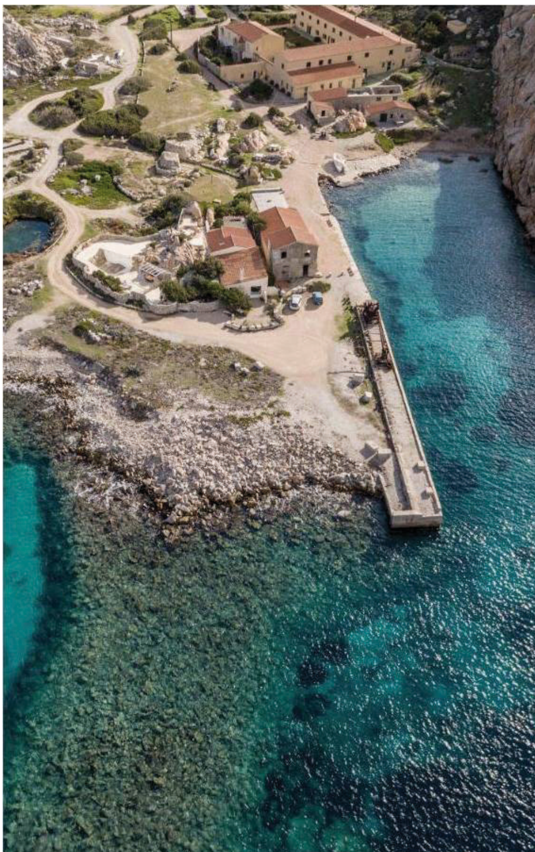
Fig. 2a. Cala Francese, foto aerea dello stato attuale nella quale è visibile il molo, gli alloggi degli operai, la direzione, i piazzali lavorazione e i depositi.
