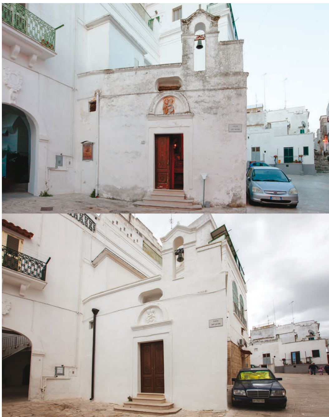
Fig. 5 Confronto ante e post operam dei lavori di restauro sulle superfici esterne della Chiesa di S. Antonio da Padova in Ginosa. Foto a cura degli autori.
