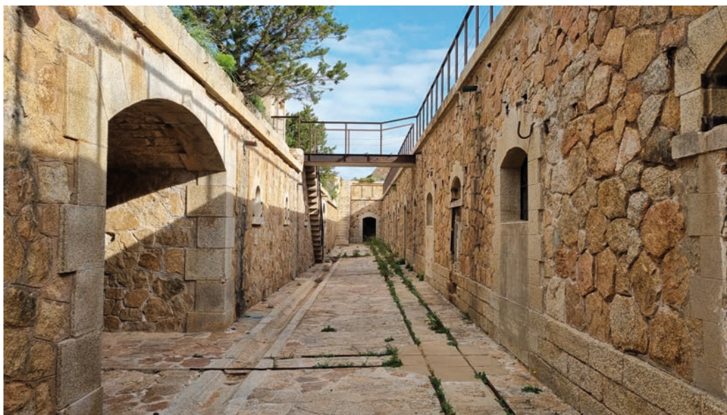
Fig. 11a. Palau (OT), forte di Capo d'Orso, veduta del corridoio di accesso alle riserve (D.R. Fiorino).
